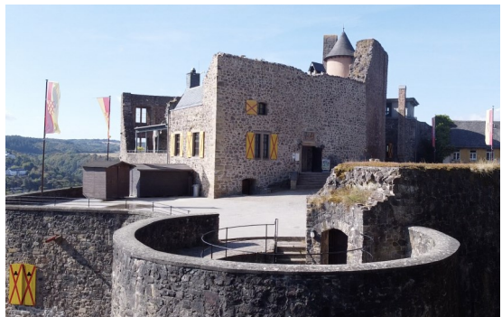
Ansicht aus Richtung Nordostturm
