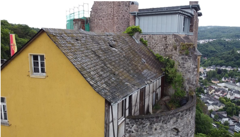
Das Menglerhaus auf dem Stumpf des Südwestturms
