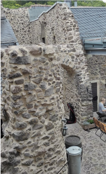
Detailansicht der Fugen
