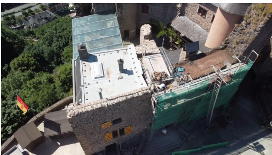
Auf der Mauerkrone über dem Eingang
